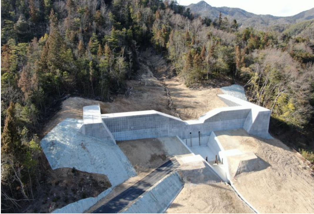
広島県災害関連緊急砂防事業, 東広島市八本松町原
